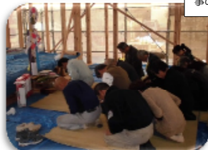
建設会社の方が祝詞を読み上げ、今後の工事の無事を祈りました。
