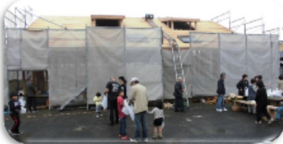
新公民館です！屋根にあるおしゃれなドーマーが外光を多く取り込み、中原町の皆さんのような明るい公民館になりそうですね。
